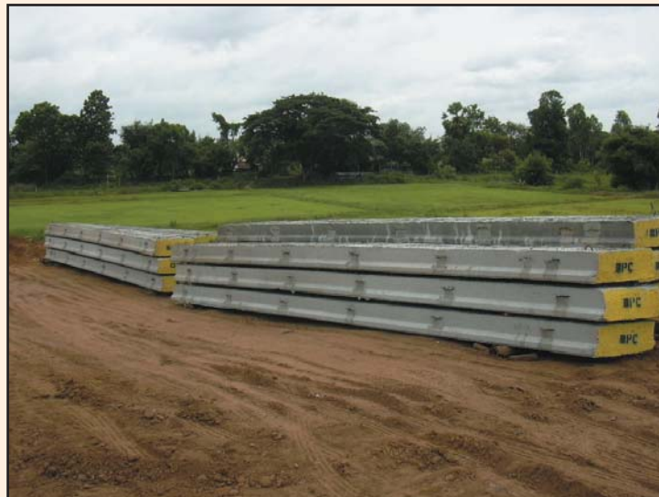
รูปที่ 4-14 การเก็บกองคานคอนกรีตอัดแรงแบบแผ่นพื้น (Plank Girder)
