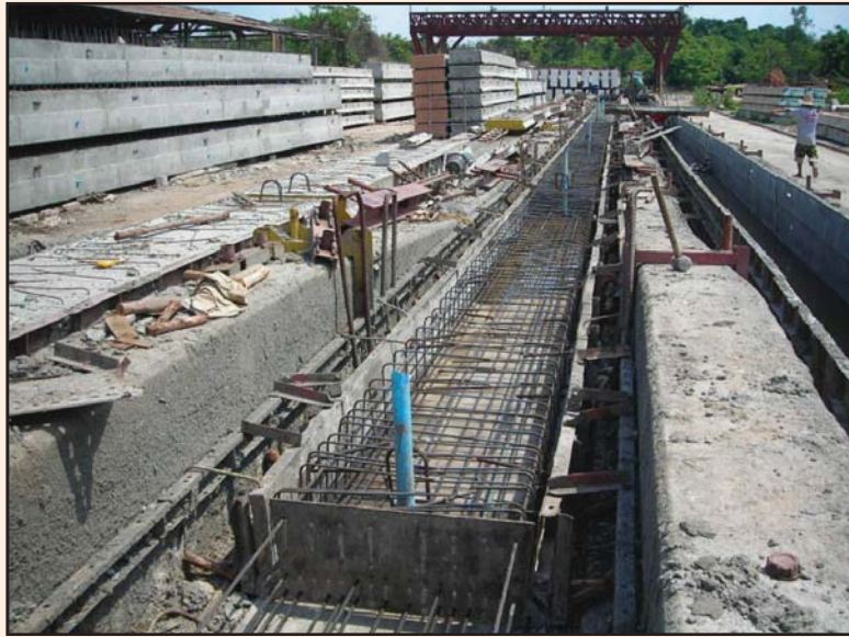
รูปที่ 4-8 ตรวจสอบเหล็กเสริมและความเรียบร้อยของแบบหล่อก่อนการเทคอนกรีต คานแบบแผ่นพื้น (Plank Girder)
