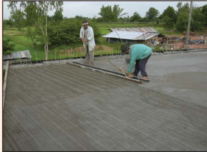
รูปที่ 4-4 การกรีดผิวหน้าคอนกรีต
