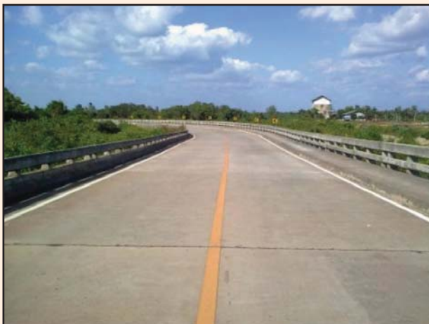
รูปที่ 4-3 พื้นสะพานแบบหล่อในที่
