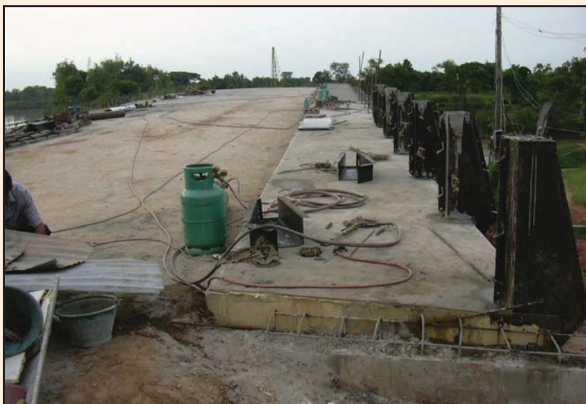
รูปที่ 4-24 การประกอบแบบและเทคอนกรีตเสาราวสะพาน
