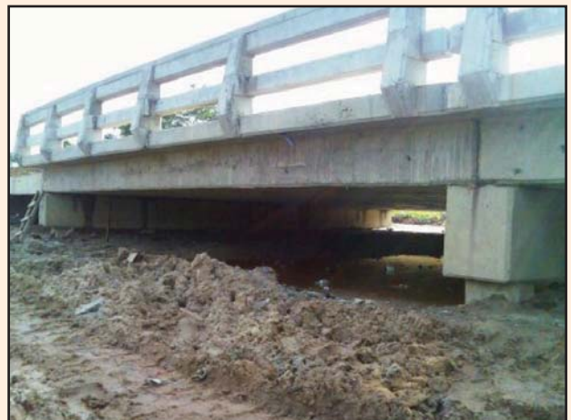
รูปที่ 4-3 พื้นสะพานแบบหล่อในที่
