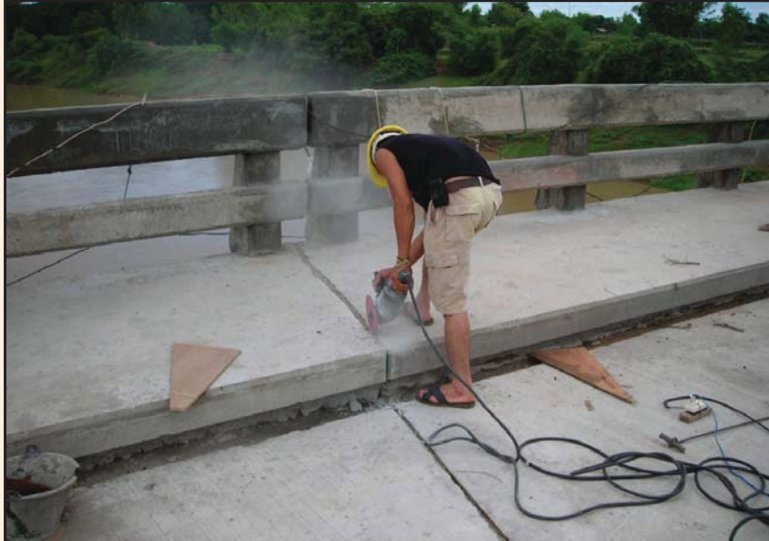
รูปที่ 4-23 การตัดแต่งรอยต่อและเซาะร่องรอยต่อระหว่างพื้นทางเท้าสะพาน
