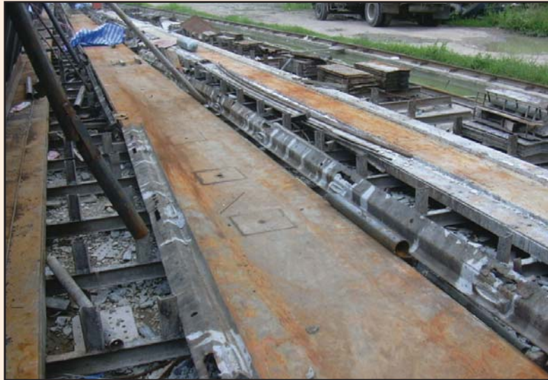
รูปที่ 4-6 ตรวจสอบพื้นแบบหล่อ
