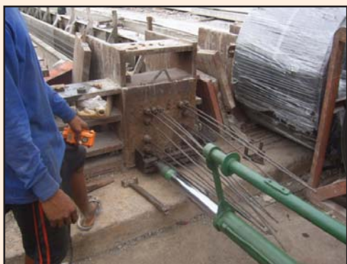
รูปที่ 4-11 การดึงลวดอัดแรง
