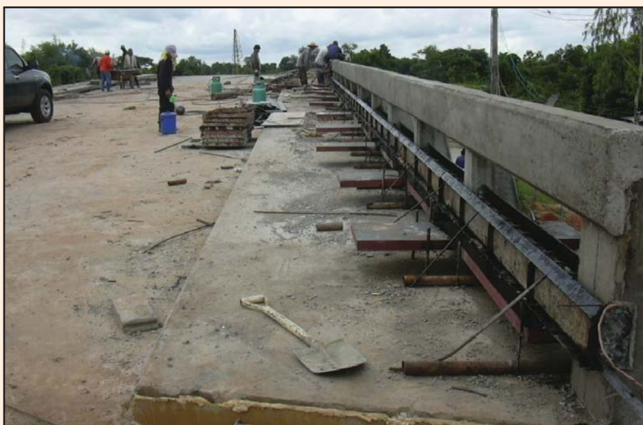
รูปที่ 4-26 การประกอบแบบและเทคอนกรีตราวสะพาน
