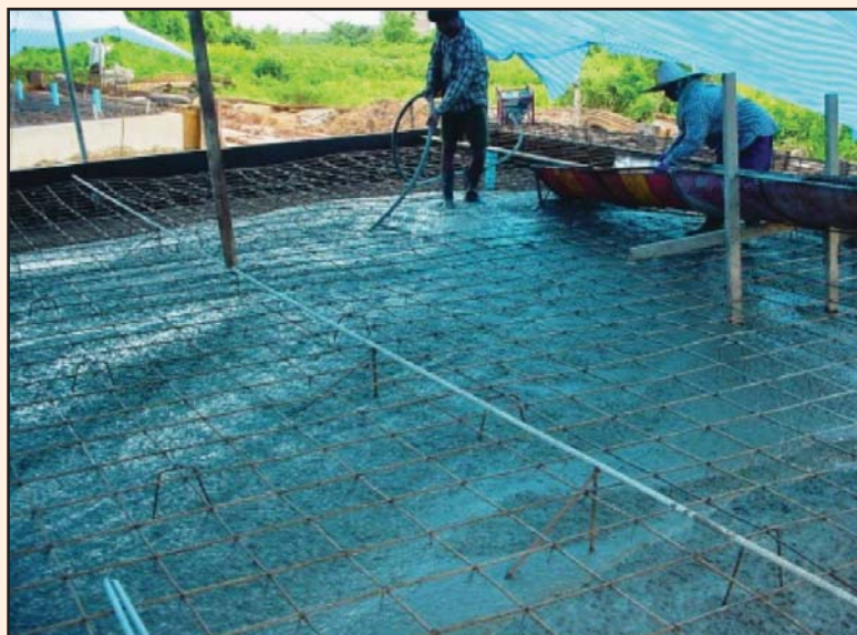
รูปที่ 4-2 เทคอนกรีตพื้นสะพานแบบหล่อในที่ (Slab Type)
