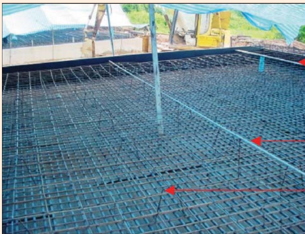
รูปที่ 4-1 เหล็กเสริมพื้นสะพานแบบหล่อในที่และการติดตั้ง Bar Chair
