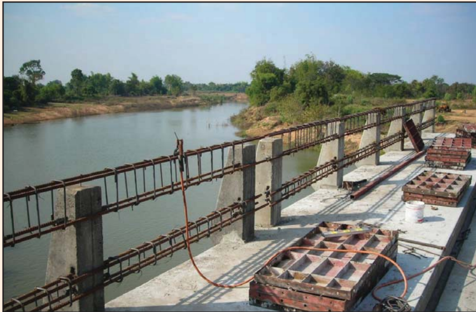
รูปที่ 4-25 การติดตั้งเหล็กเสริมราวสะพานบนเสาราวสะพาน
