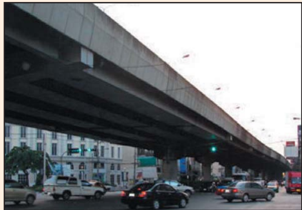
รูปที่ 1-2 สะพานบก
