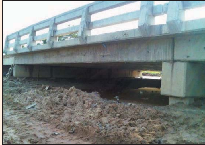
รูปที่ 1-7 สะพานชนิดพื้นคอนกรีตเสริมเหล็กหล่อในที่
