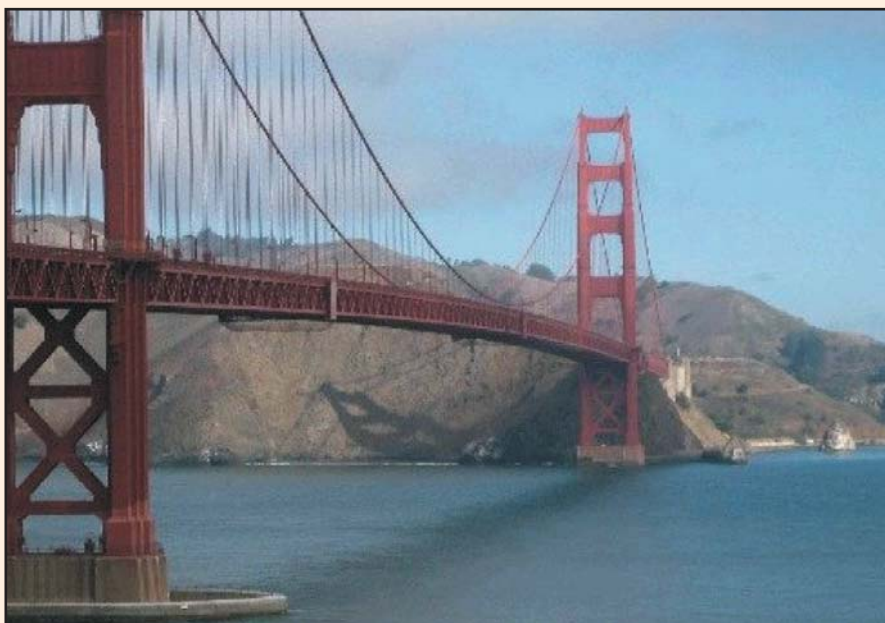
รูปที่ 1-15 สะพานแขวน (Suspension Bridge)
