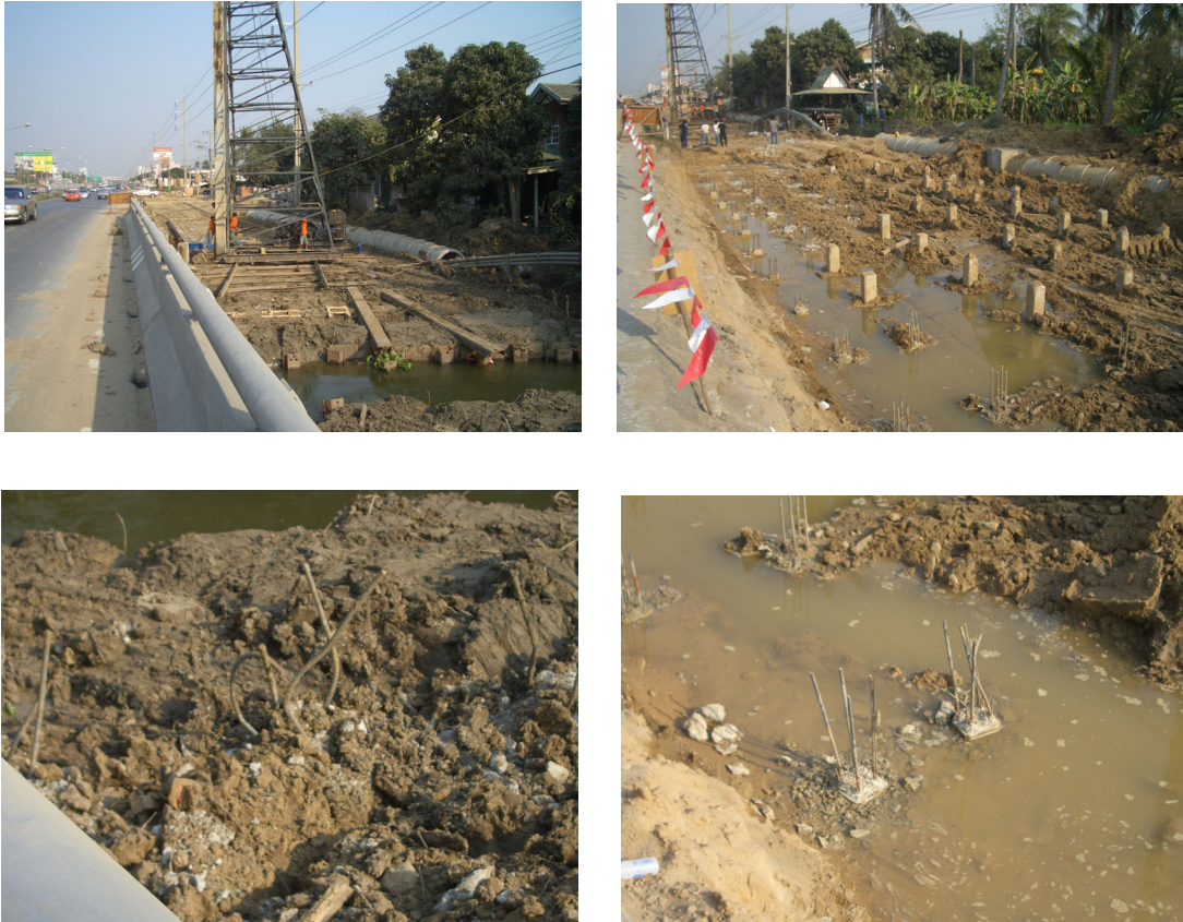
รูปที่ 4-11 การตอกเสาเข็มฐานรากและการสกัดหัวเข็ม
