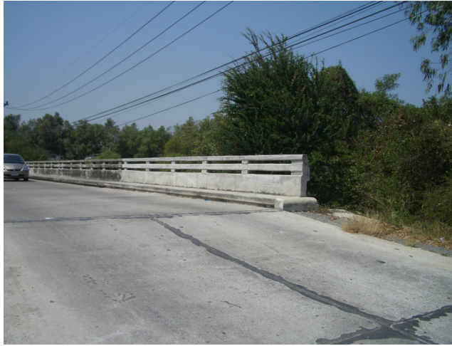
รูปที่ 4-16 ช่วงคอสะพานที่ไม่มีการตอกเข็มพืด
