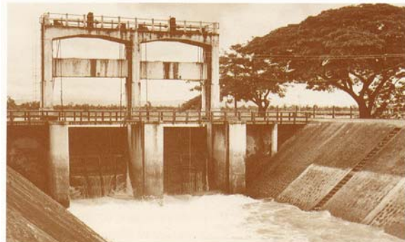
ประตูระบายน้ำ
