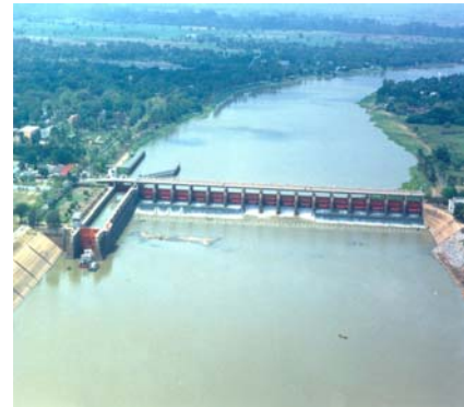
(ข) เขื่อนระบายน้ำเจ้าพระยา
