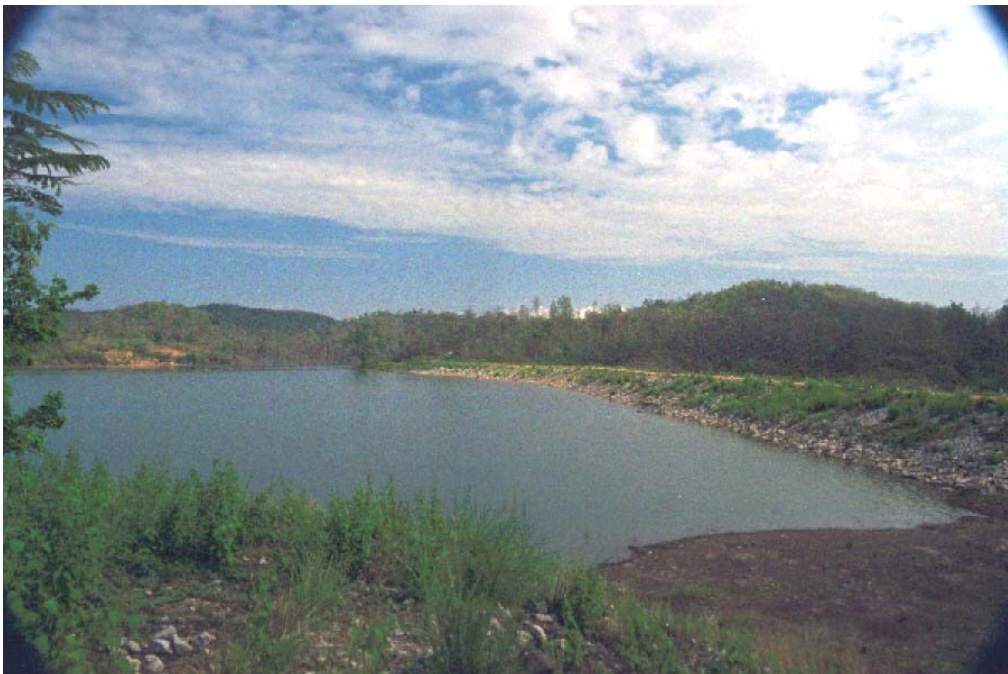
รูปภาพก่อนและหลังโครงการขุดสระเก็บน้ำ
