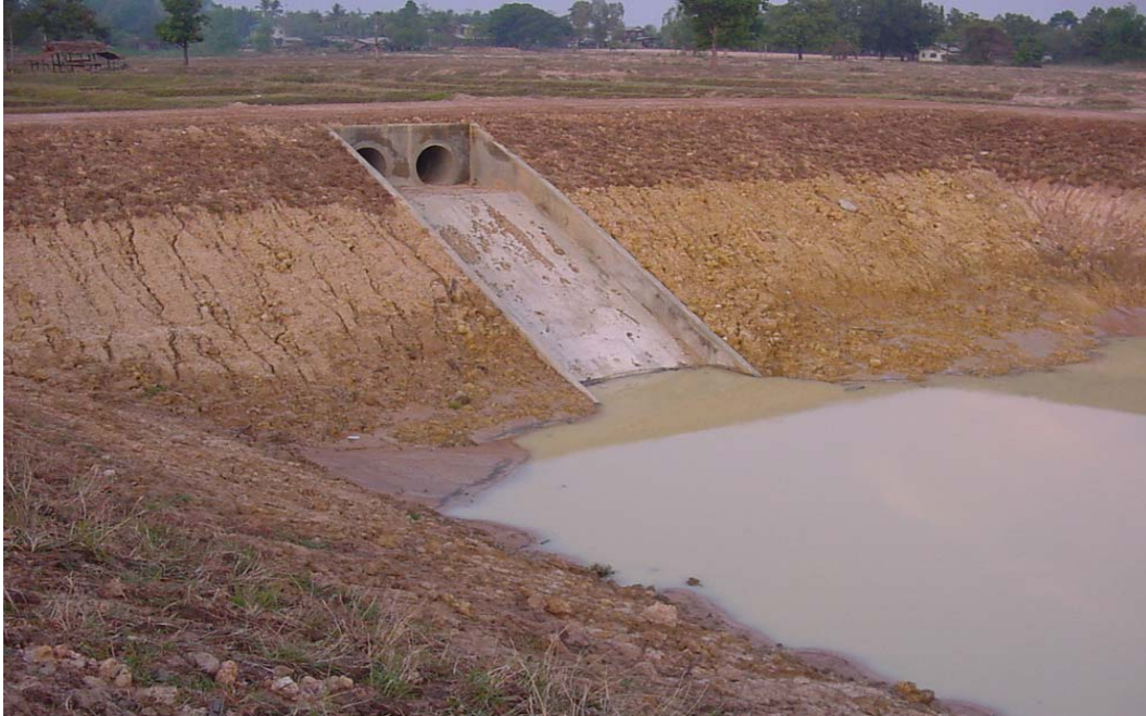
รูปที่ 2.3 แสดงอาคารทางน้ำเข้า
