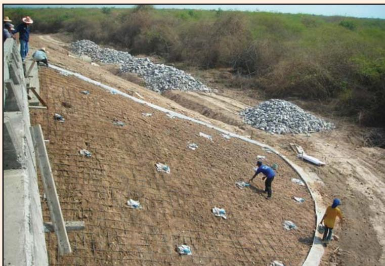
รูปที่ 5-3 งานติดตั้งท่อระบายน้ำและตะแกรงเหล็กเสริมตาดคอนกรีต
