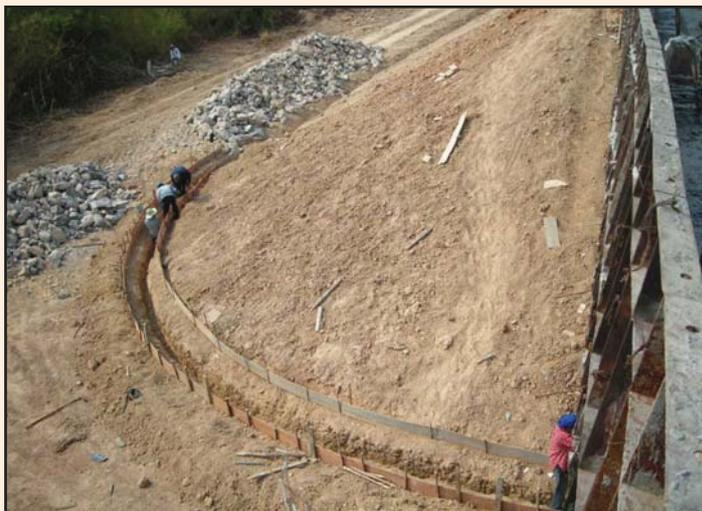
รูปที่ 5-1 งานดินถมรองรับดาดคอนกรีตป้องกันคอสะพาน และการเตรียมพื้นที่ก่อสร้างคานขอบ (Shear Key)
