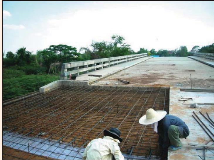
รูปที่ 5-8 เหล็กเสริม Approach Slab (ช่วงแรกที่พาดบนตอม่อตบิริม) และการปูแผ่นพลาสติกใต้อรอยต่อแผ่นพื้นคอนกรีต
