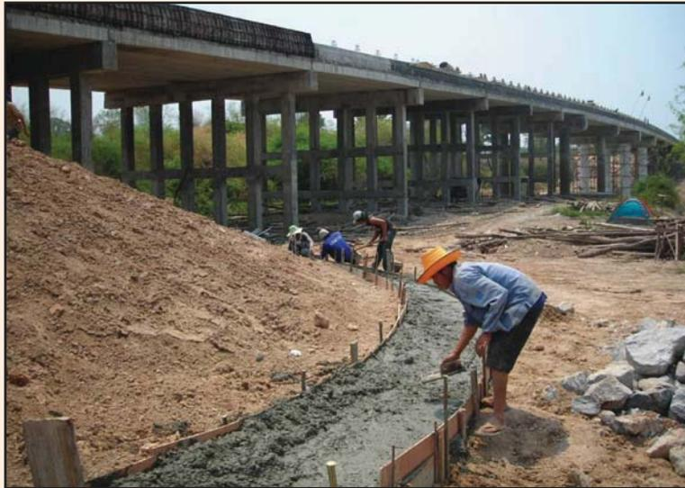
รูปที่ 5-2 งานเทคอนกรีตหล่อคานขอบ (Shear Key)
