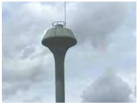
รูปที่ 22 สายล่อฟ้าบนหอถังสูง
