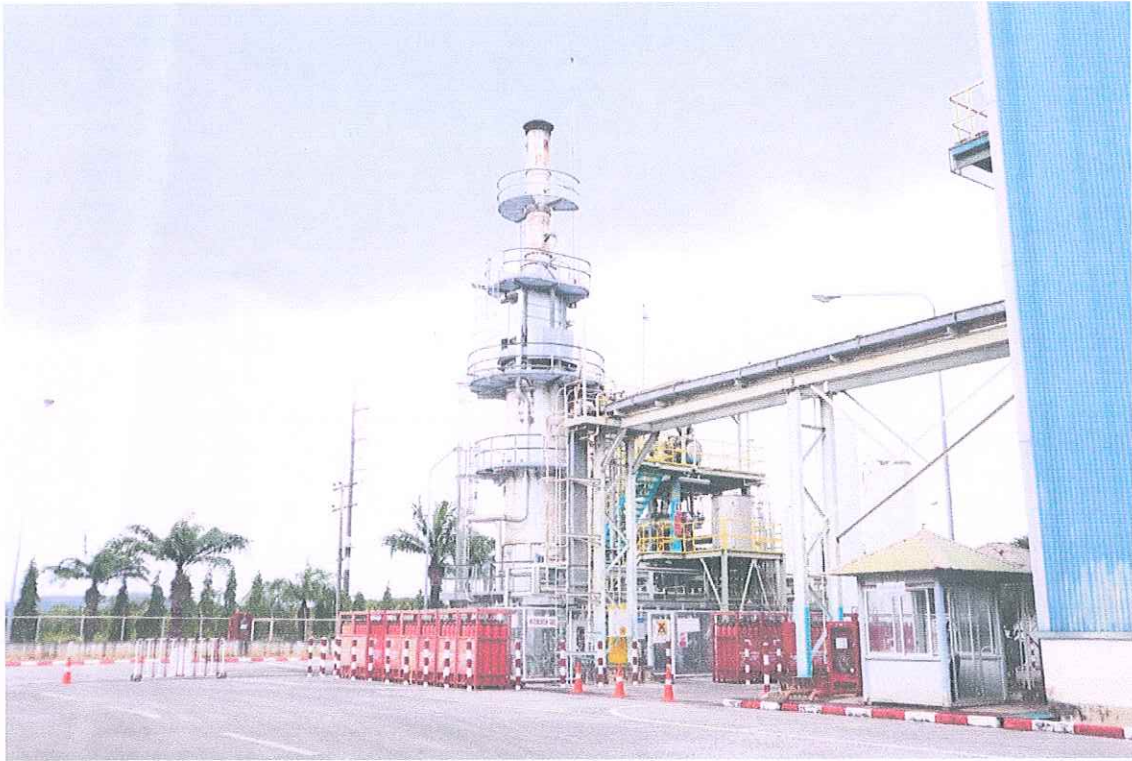
รายการที่ 4 ปล่องระบายควัน
