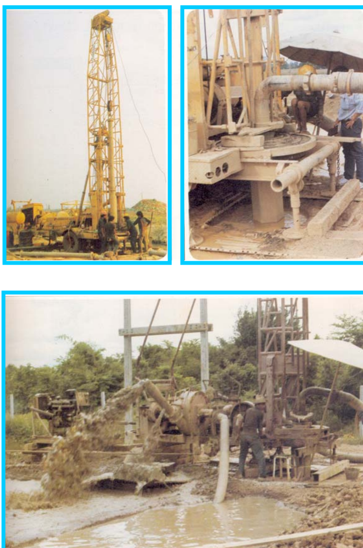
ภาพที่ 10.1 การขุดเจาะบ่อน้ำใต้ดินขนาดใหญ่
