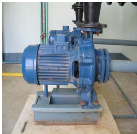
(6) เครื่องสูบน้ำดี (แบบหอยโข่ง)
