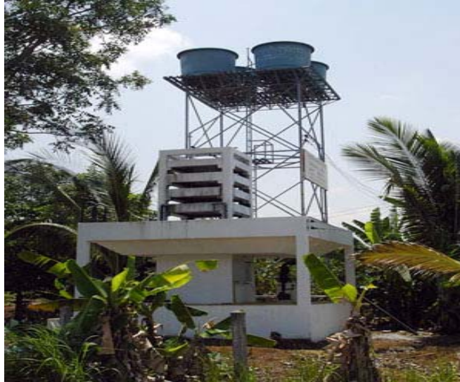
รูปที่ 17 ตัวอย่างรูปแบบระบบประปาหมู่บ้านของกรมโยธาธิการ
