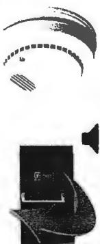
► ติดตั้งอุปกรณ์เตือนควันไฟ (Smoke Alarm) บริเวณโถงหน้าห้องนอน และบริเวณห่างจากครัวประมาณ 3 ถึง 5 เมตร รวมทั้งให้ทดสอบอุปกรณ์เตือนควันไฟทุกเดือน
